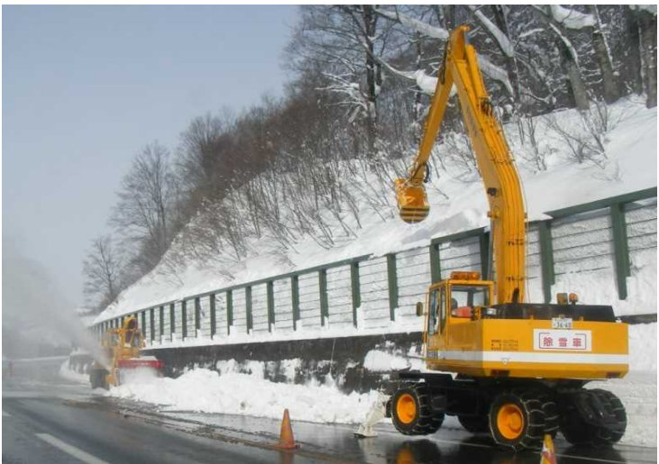
ロータリ除雪車&雪庇(せっぴ)処理車 雪庇処理車で高い位置の張り出した雪を落としてロータリ除雪車で遠くへ飛ばす作業をしています。
