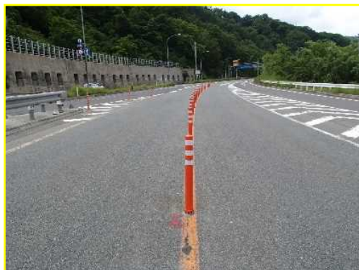
センターにポストコーン設置
