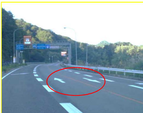
進行方向矢印の路面標示
