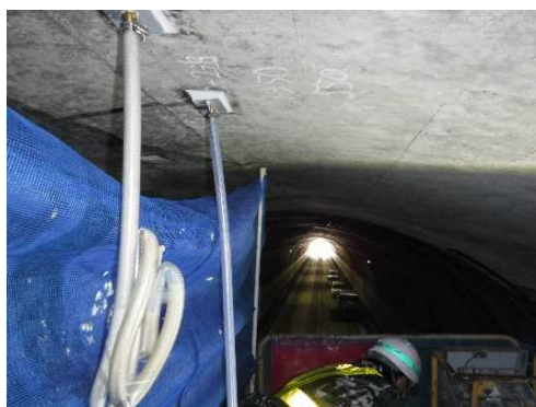
4. 穴に取り付けた部品に、ホースをセットします。
