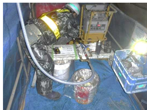
6. 圧力が規定値まで上昇したら 注入ストップ。ホースを取り外します。
