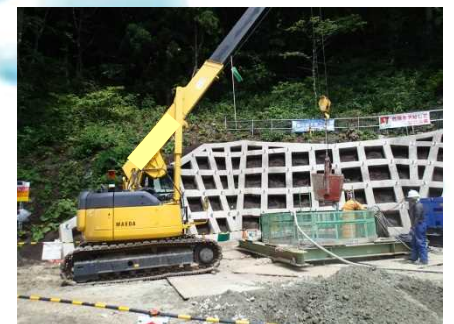
井戸の中での作業なので、排気ガスが出ないように(酸欠防止)、電動のミニバックホウをリモコンで操作し掘り進めます。集めた土砂はクレーンで井戸の外に出します。
