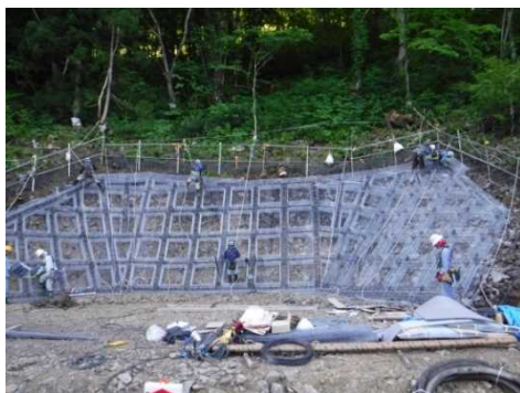
井戸を掘る前に周りの地盤を固めしっかりしたものにしています
