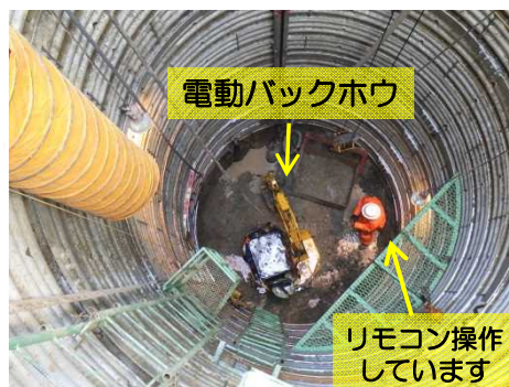
井戸の中での作業なので、排気ガスが出ないように(酸欠防止)、電動のミニバックホウをリモコンで操作し掘り進めます。集めた土砂はクレーンで井戸の外に出します。
