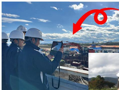
タブレットを使用しサイホンを3Dで確認することができます。立体表示で施工のイメージがしやすいです。
