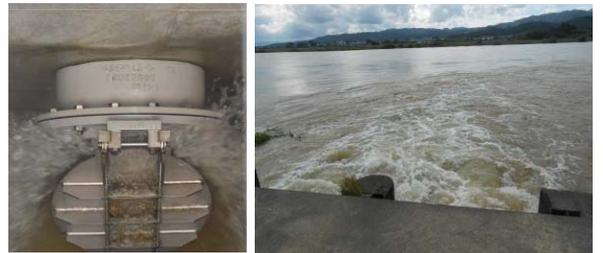
▲村山市大旦川排水機場では内水排除のため排水ポンプ全10基がフル稼働し、堤内地(大旦川)の水を最上川へ、毎秒10トンの排水作業を行いました。
