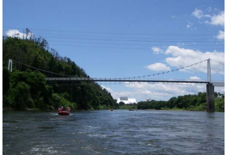
竜神の吊橋(村山市)。橋脚に流木やゴミが溜まっていないか、橋に異常がないかを確認します。
