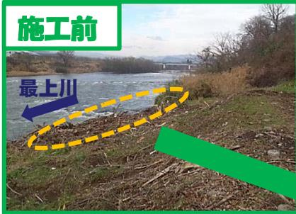
工事内容：平成26年7月9日からの降雨による洪水により被災した護岸の復旧工事を行っています。
