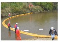
水面にフェンスを張って 油の流れを止め、吸着 マットで流れ出た油を回 収します。
