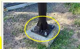
照明灯のボルトキャップの外れを確認
