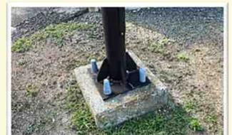
ボルトキャップの設置完了!
