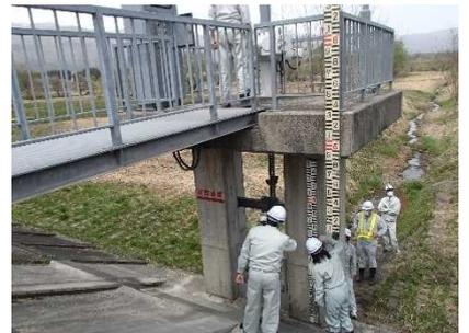
4月14・18・21日の3日間、管内55箇所(＋<sup>かいしょうがわ</sup>貝生川排水樋管〈白鷹町土地改良区に委託〉、<sup>みのわだ</sup>箕和田排水樋管〈白鷹町農林課に委託〉)の樋門・樋管で、各箇所の水門等水位観測員と山形河川国道事務所職員が、ゲートの操作方法や動作確認、設備点検を行いました。
