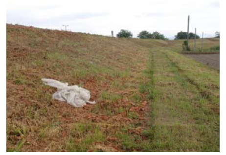
《18》最上川左岸 No.21- 元宿川樋門下流 川裏上部法面 農業用廃ビニールの投棄
