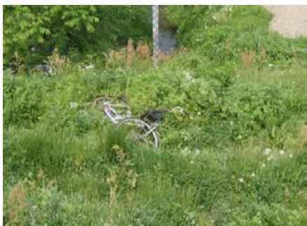
《14》最上川左岸 No.58- 洲島第2樋管 裏小段 損壊した自転車の投棄
