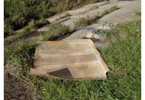
《33》 元宿川右岸 No.3- 元宿川橋上流 川表小段へのアクリル板の投棄
