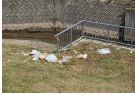
《17》最上川左岸 No.94- 谷地堰樋管 堤内水路脇 家庭雑貨ゴミの投棄
