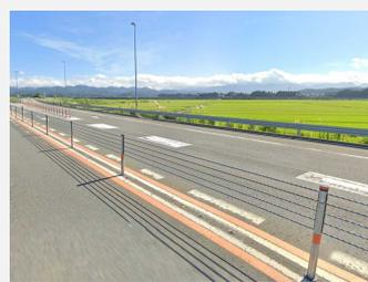
車両が衝突した際に中間支柱が変形して倒れ、ワイヤロープで受け止め衝撃を緩和します。幅員のとれない2車線道路の中央分離帯へ設置することで、車両が対向車線へ飛び出すことを防ぎ、安全性が大幅に向上します。
