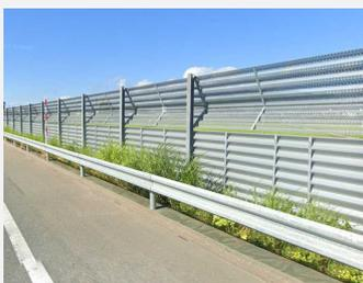
吹雪対策のために防雪板の柵前後の風速や風の流れを制御し、道路の吹きだまり防止や視界不良を軽減します。
