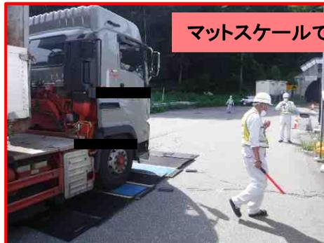
車体の高さ・幅・長さの計測
