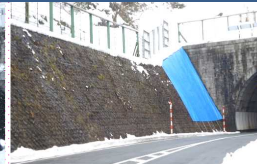
擁壁にブルーシート設置
