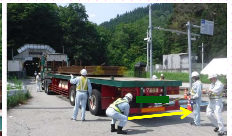
車体の幅を測定
