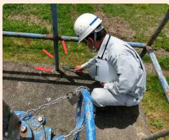
▲ 操作台を打音検査で確認
