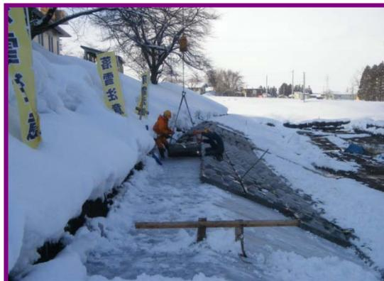
↑大型ブロックを設置しワイヤーで連結中↑
