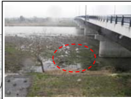
右岸 No.69+100 さくら大橋上流 橋の上からの ゴミの投げ捨てがみられる (河川愛護団体によるゴミ 回収後の状況)
