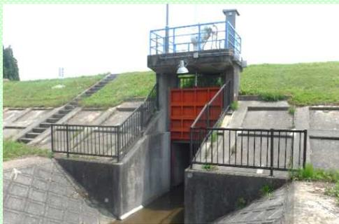
河川の堤防に設置されている施設。大雨で河川の水位が上がった際に、ゲートを閉めることで、河川から住宅地などへの水の逆流を防ぐものです。
