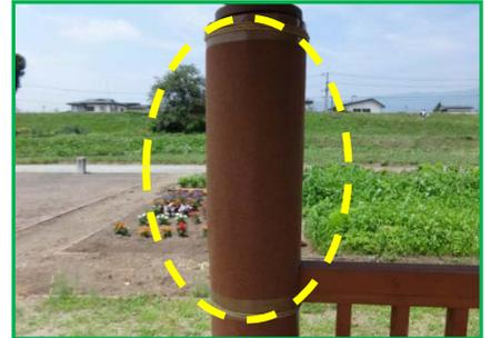
＜ 四阿の支柱の一部腐食 ＞ → シートで養生(7月19日補修完了)
