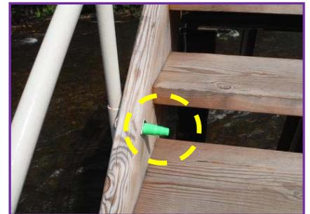
＜ ボルトの向きが逆 ＞ → 保護カバーの設置(7月19日補修完了)
