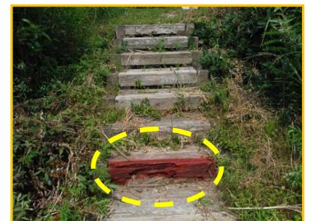
＜ 階段の一部腐食 ＞ → 赤く着色して注意喚起(7月18日補修完了)
