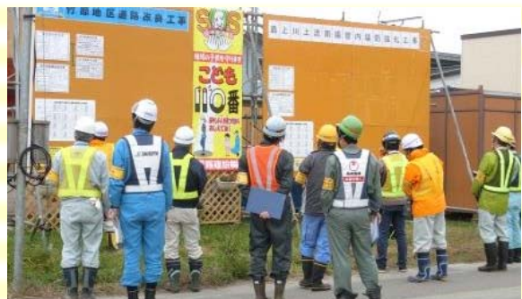
現場事務所の掲示板の点検
