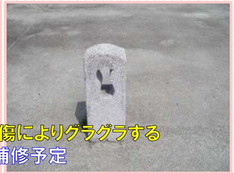
車止め1対、損傷によりグラグラする
