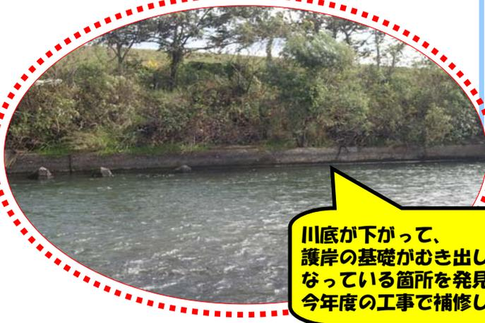
川底が下って、護岸の基礎がむき出しになっている箇所を発見!! 今年度の工事で補修します。
