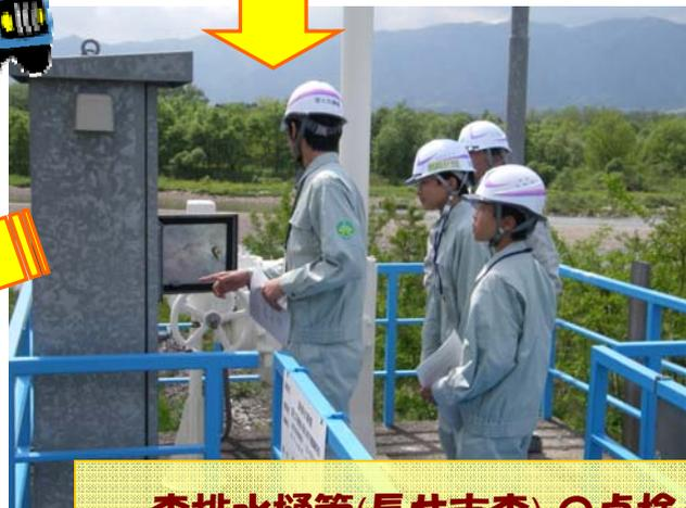
森排水樋管(長井市森)の点検と、実際にゲートを操作してみました。河川の増水時は、操作員が出勤し、ゲートを閉めて水の逆流を防ぎます。
