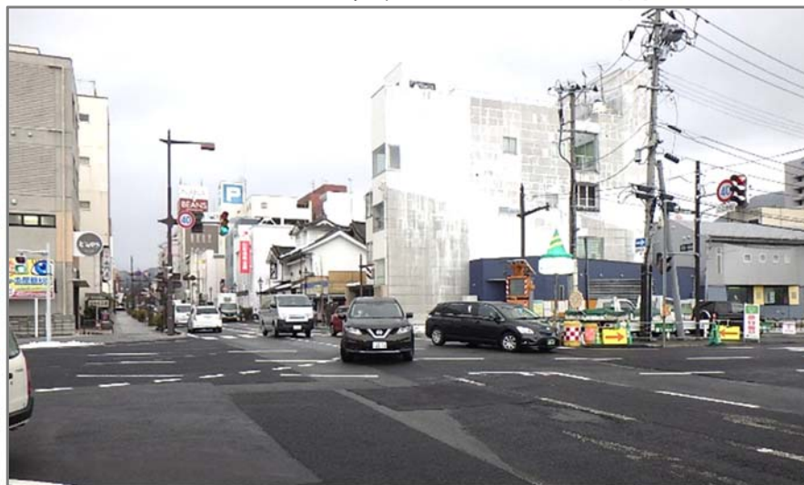
■ 施工後の状況写真 (乗用車右折) ②
