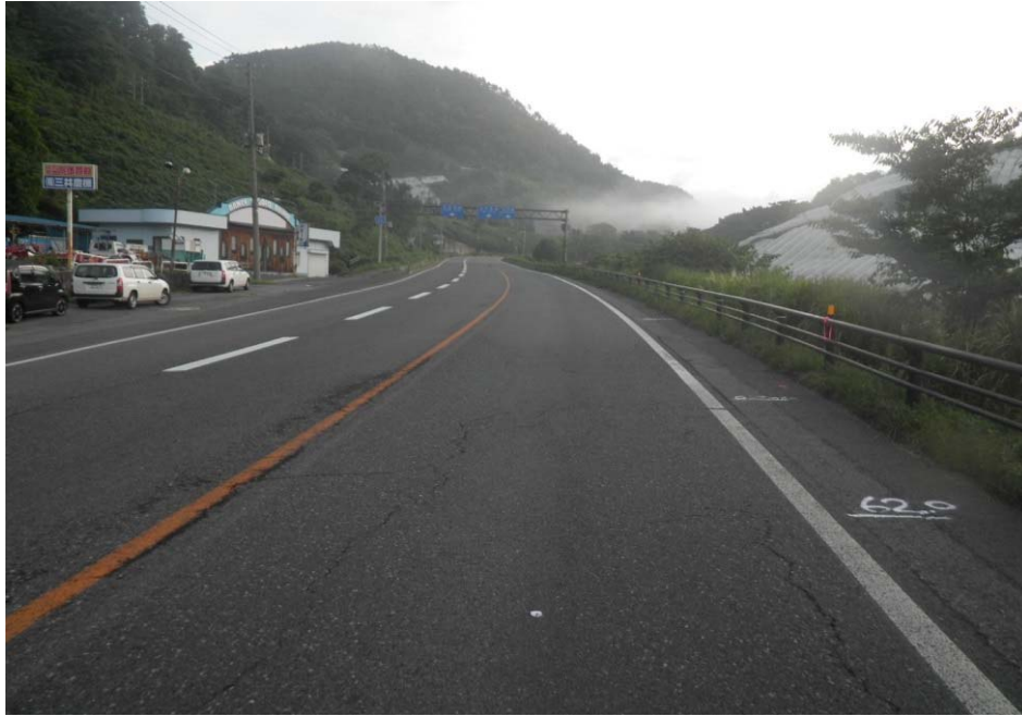
【施工前 R13 62.0kp(上り)】
