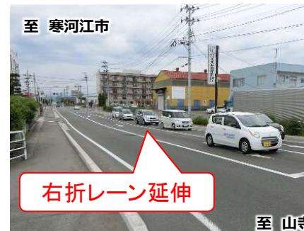
【④方向：対策後】
