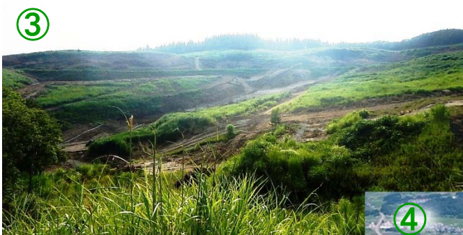
新庄市：協和木材（株） 事業中（造成工事中）
