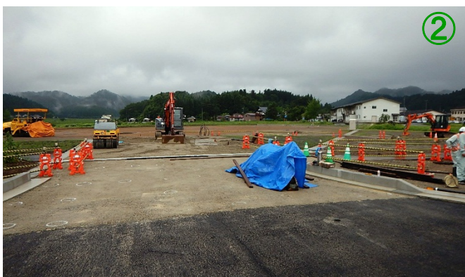
金山町：アキレス(株) 工場建設中
