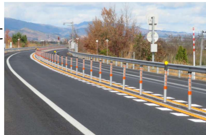
中分ワイヤロープ設置状況
