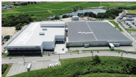
EV車・産機市場向け生産能力増強に向けた新棟増床 (2023.06)
