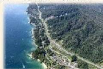
三陸沿岸道路（岩手県山田町）
