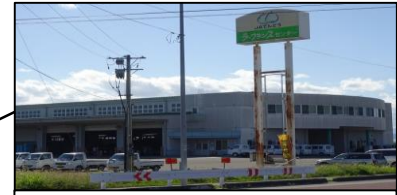
JA天童ラ・フランスセンター ・義援物資集積配分拠点及び災害対応上必要とされる活動拠点「防災拠点」
