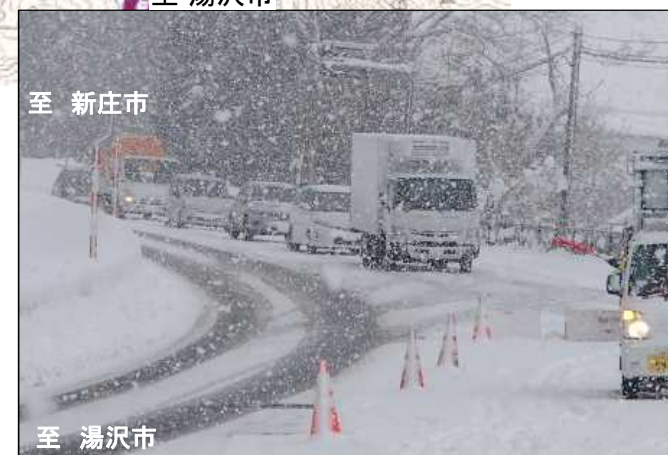
▲ 運搬排雪作業時の国道13号の交通状況
