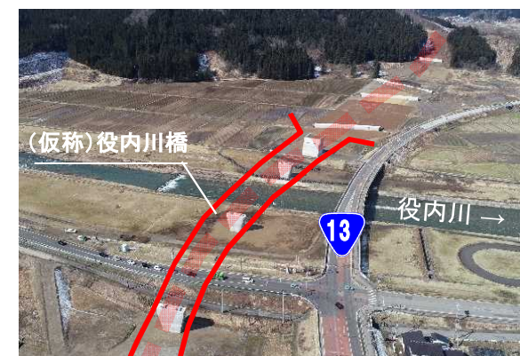
▲(仮称)役内川橋付近の航空写真 [R2.3撮影]
