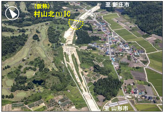
▲① (仮称)村山北(1)IC付近の航空写真[R2.8撮影]
