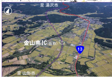
▲ ①(仮称)金山南IC付近の航空写真 [R1.9撮影]
