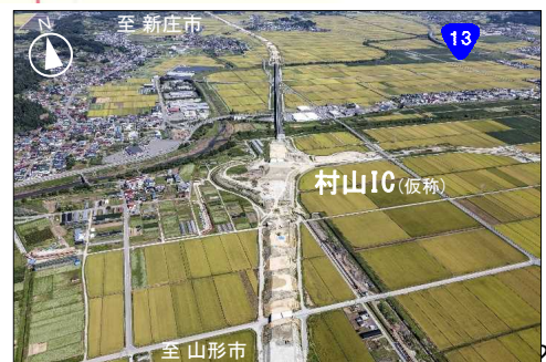
▲ ②(仮称)村山IC付近の航空写真 [R1.9撮影]
