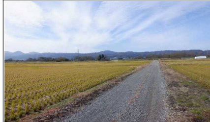
農道 八ヶ郷第16、17号道路 付近
