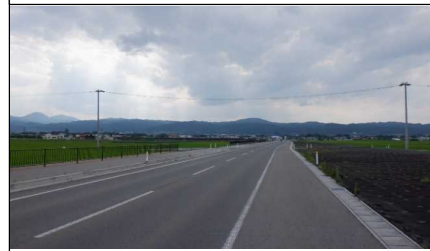
県道 山形山辺線BP 付近
