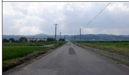
町道 北垣船町線 付近
