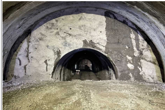
高屋トンネル(切羽写真)
