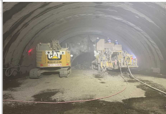
高屋トンネル(切羽掘削状況)
