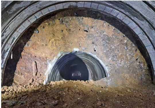
高屋トンネル(切羽写真)
