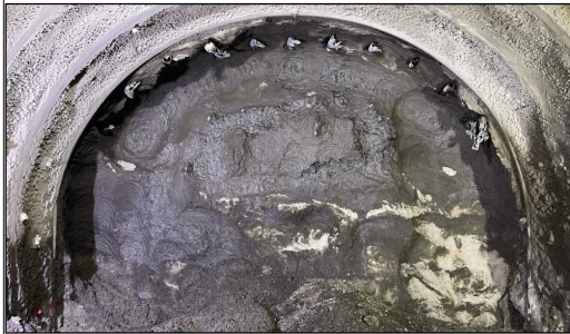
高屋トンネル(切羽写真)
