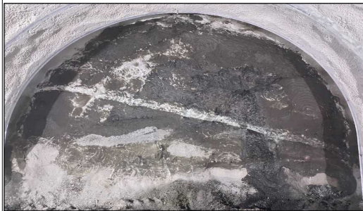
高屋トンネル(切羽写真)
