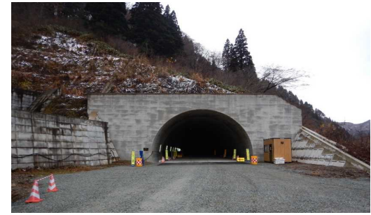
猪ノ鼻トンネル(新庄側)
