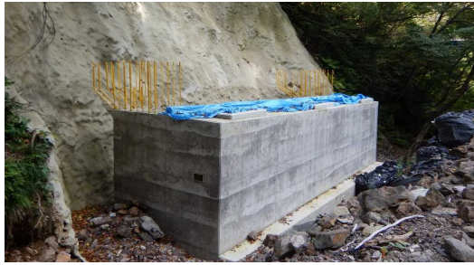
有田沢橋酒田側橋台
