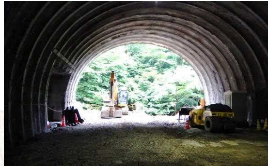
猪ノ鼻トンネル 掘削・覆工
