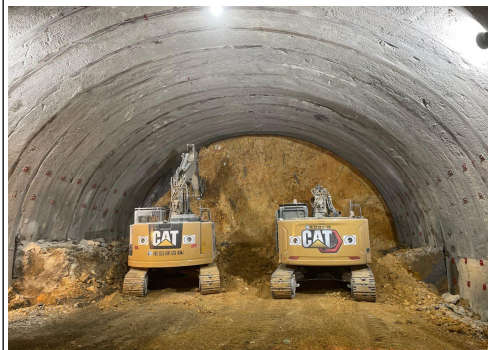
金山第一トンネル(掘削写真)
