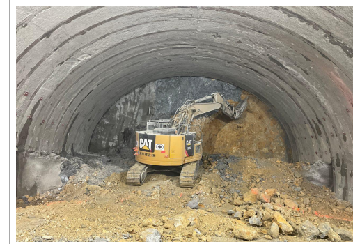
金山第一トンネル(掘削写真)
