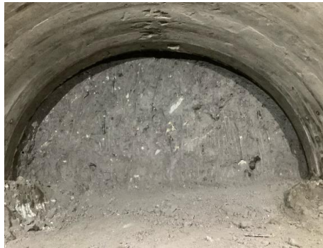
金山第一トンネル(切羽写真)
