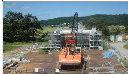
荒屋地区 (湯沢方向)
