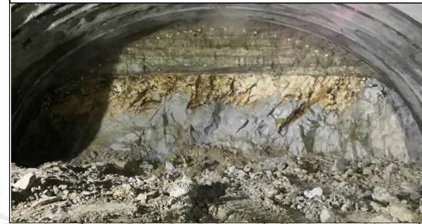
金山第一トンネル(切羽写真)
