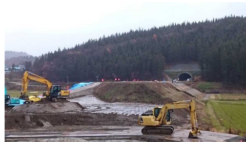
岩清水トンネル
