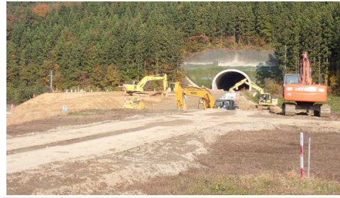
岩清水トンネル
