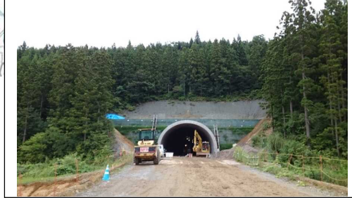
岩清水トンネル
