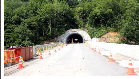
前波トンネル
