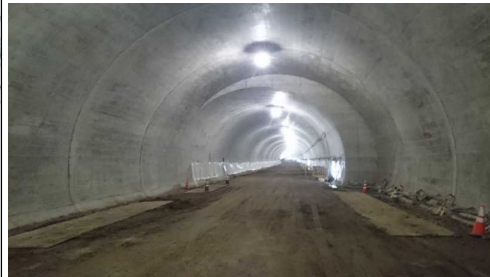
岩清水トンネル
