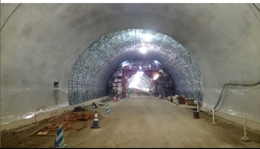
岩清水トンネル
